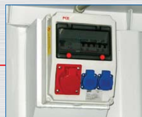
Електрическо табло с вграден предпазител
