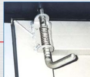
2 вътрешни поцинковани заключалки
